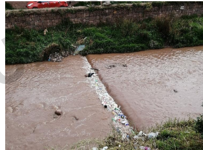
Imagen N° 42: Acumulación de desechos en el Rio Huatanay.
